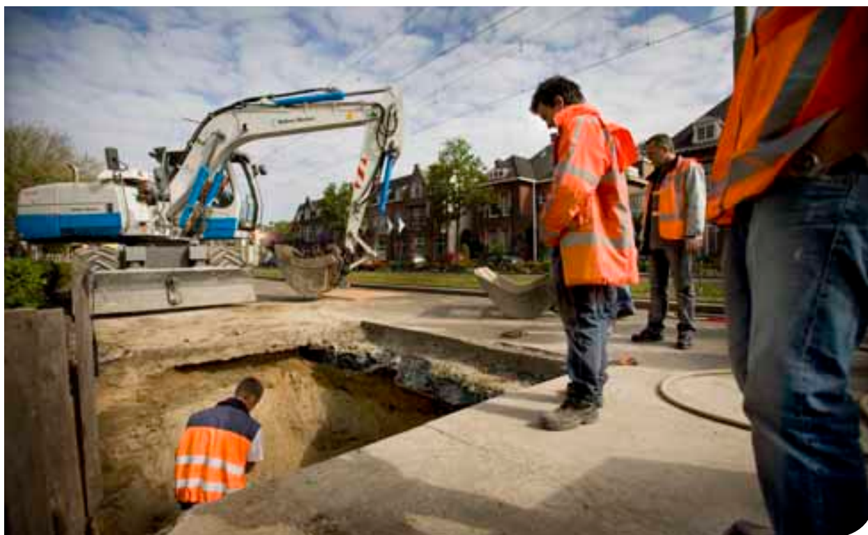
Grondwerkzaamheden, Den Haag
